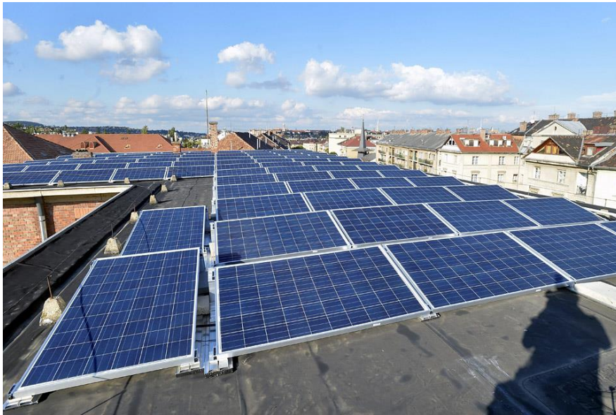
6. ábra Tetőre szerelt napelemes rendszer (Forrás: MTI/Máthé Zoltán)
