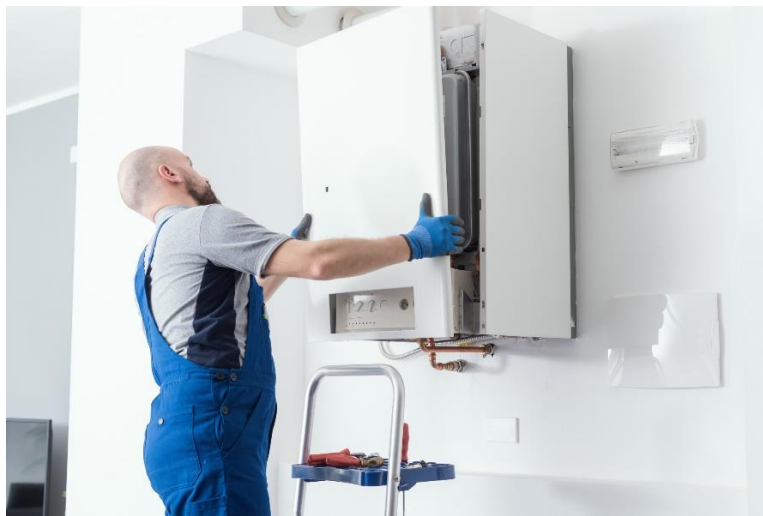
5. ábra Kazáncsere (Forrás: Home Care Heating)
