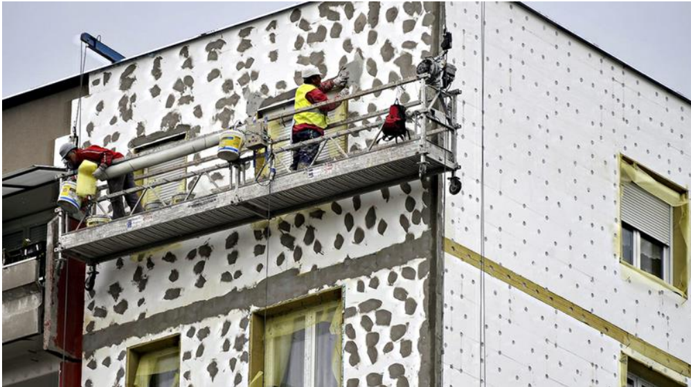
1. ábra Külső falazat hőszigetelése (Forrás: MTI/Beliczay László)
