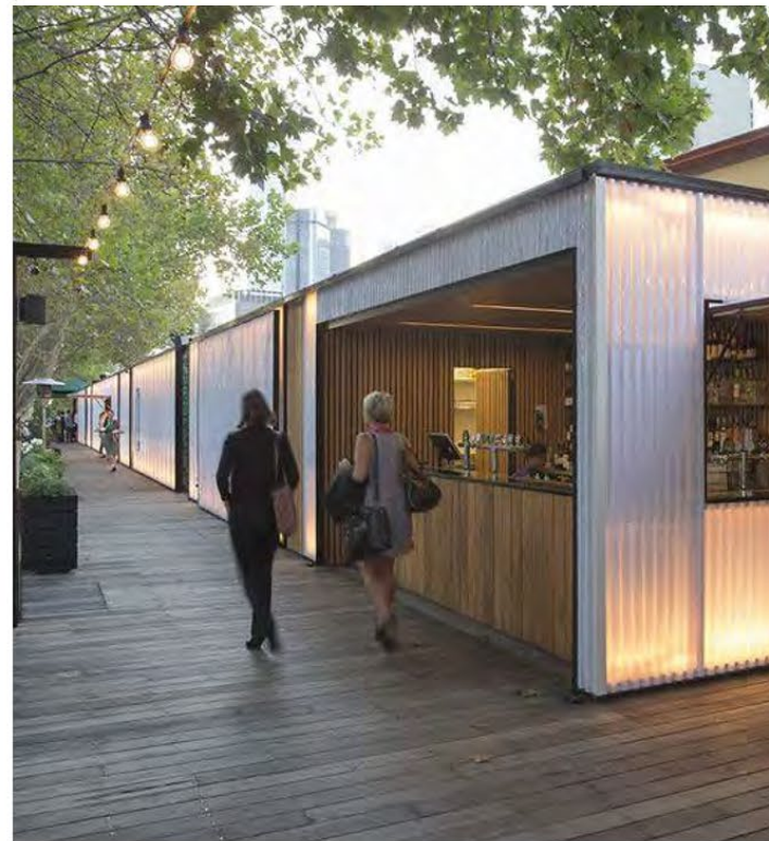
polikarbonát homlokzatburkolat
