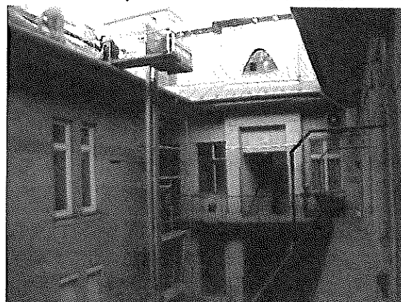
udvari homlokzat, tetőfelújítás
