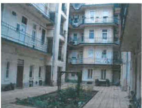
udvari homlokzat, udvar
