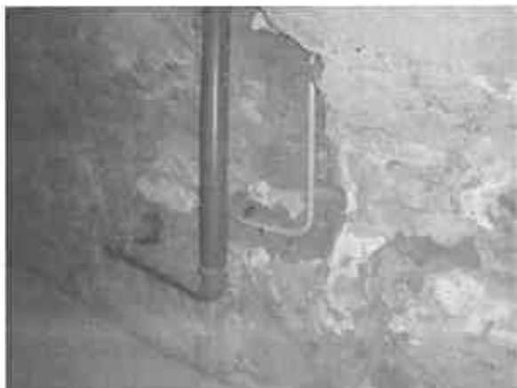
társasházi közműhálózat vezetékei
