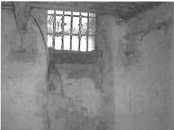
utcafronti homlokzati nyílászáró
