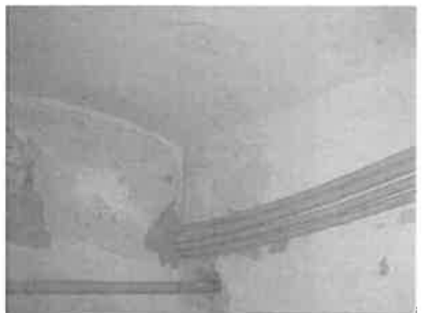
társasházi közműhálózat vezetéke
