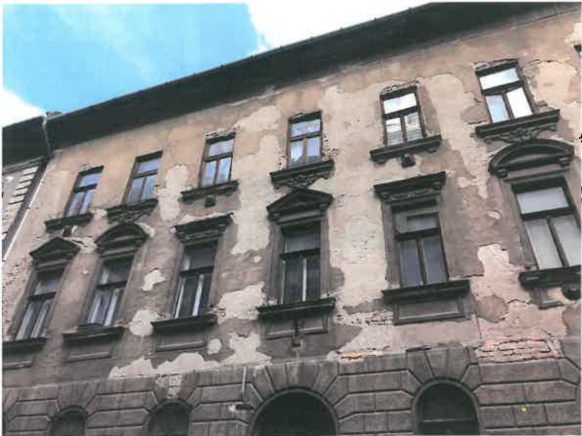
Márton utcai homlokzat
