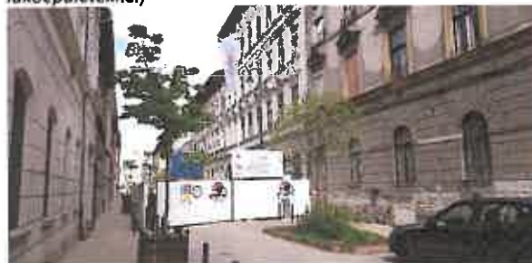
Gát utca 24-26. felújítás alatt
