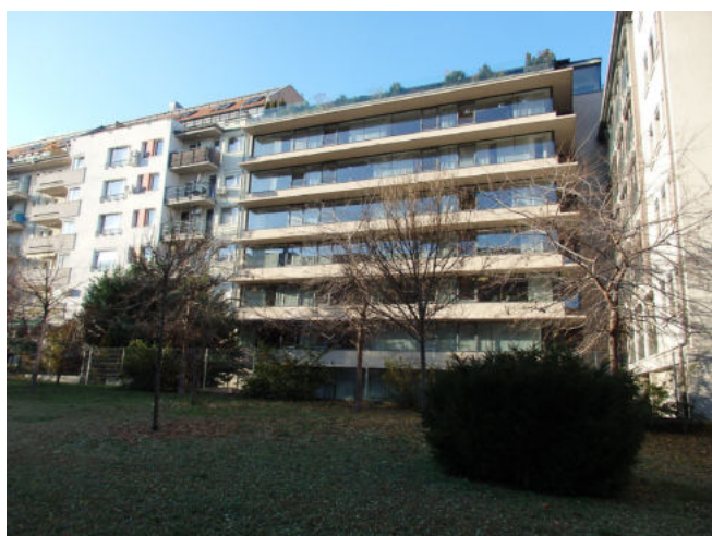
Ipar utcai épület homlokzata
