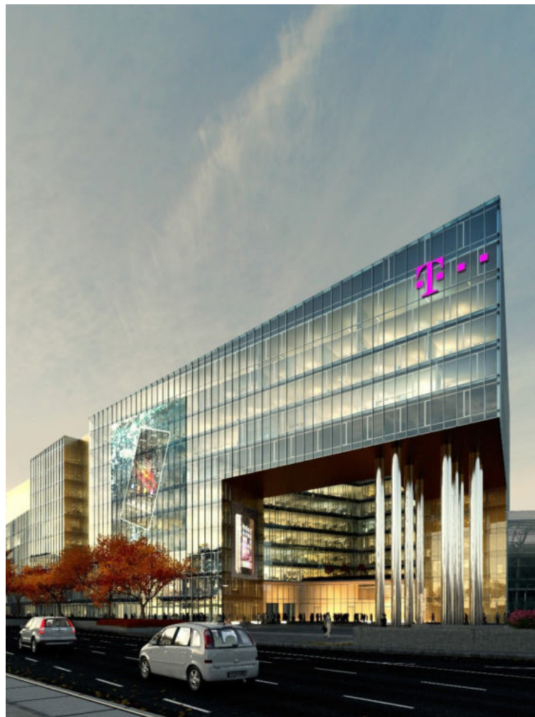
az épülő székház látványtervei és az építkezés
