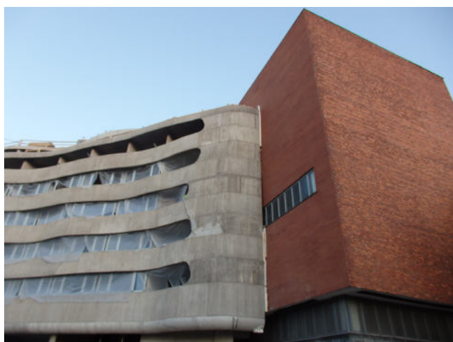
épülő szálloda a Csarnok téren
