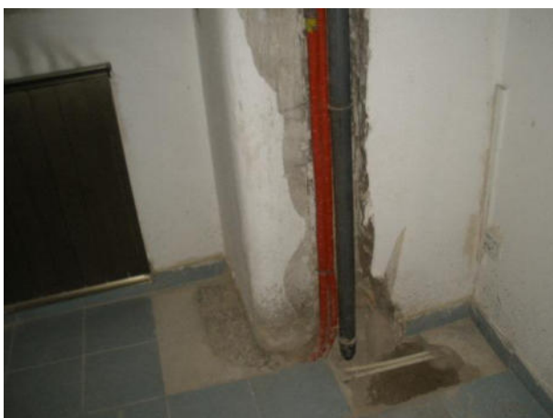
felbontott aljzat, kartonozó
