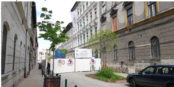
Gát utca 24-26. felújítás alatt
