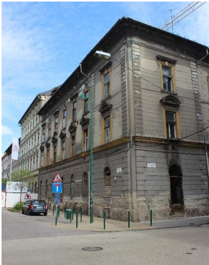
Márton utca 8/a. homlokzat
