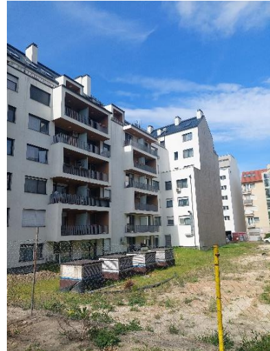
Az újépítésű Lenhossék utca 11-13. északi oldala
