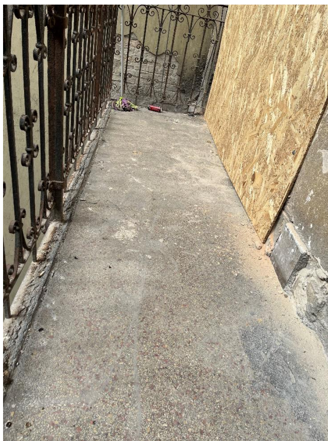
24. számú kép: 2. emeleti függőfolyosó – felülről nézve – 7
