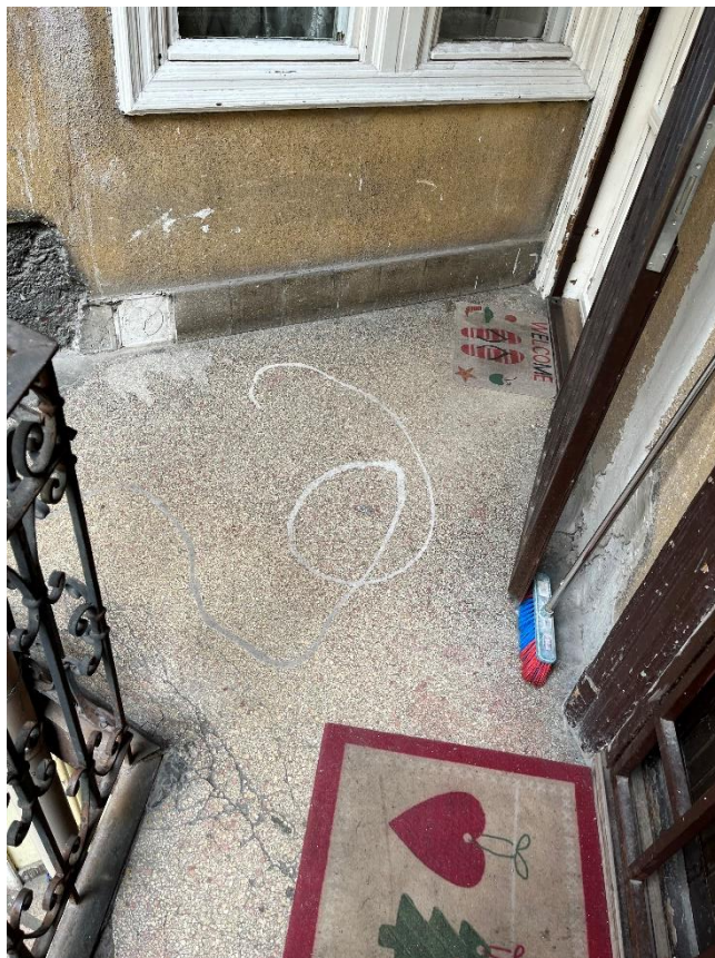
21. számú kép: 2. emeleti függőfolyosó – felülről nézve – 4
