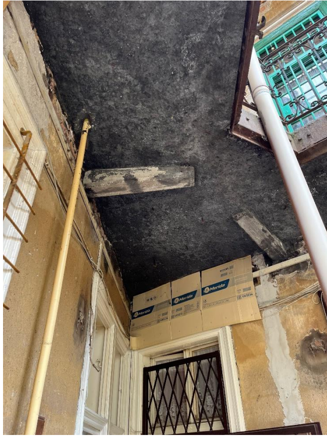
27. számú kép: 3. emeleti függőfolyosó – alulról nézve – 3
