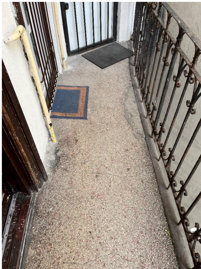
33. számú kép: 3. emeleti függőfolyosó – felülről nézve – 3
