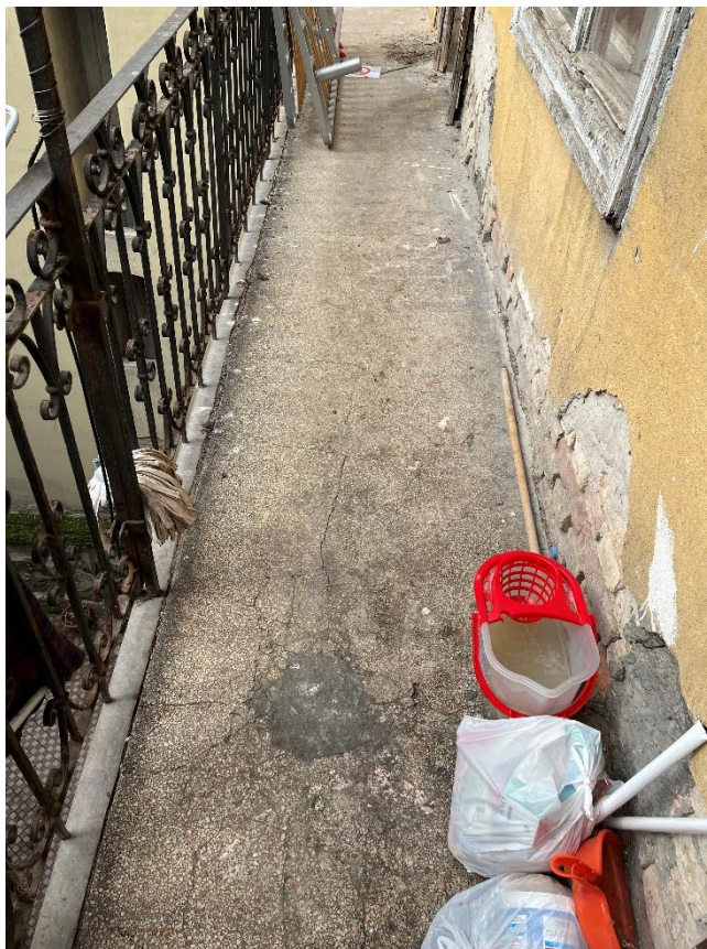
39. számú kép: 3. emeleti függőfolyosó – felülről nézve – 9
