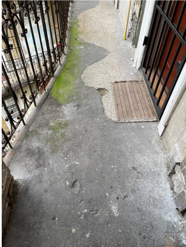
35. számú kép: 3. emeleti függőfolyosó – felülről nézve – 5
