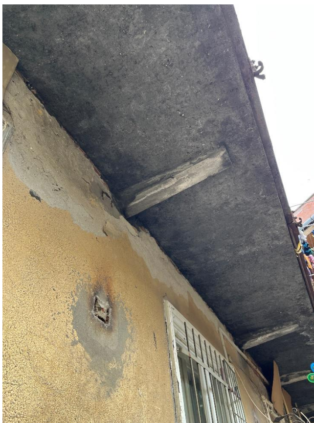
26. számú kép: 3. emeleti függőfolyosó – alulról nézve – 2
