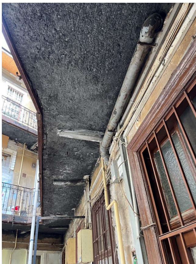
14. számú kép: 2. emeleti függőfolyosó – alulról nézve – 3
