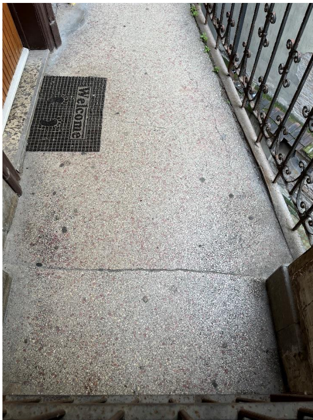
18. számú kép: 2. emeleti függőfolyosó – felülről nézve – 1
