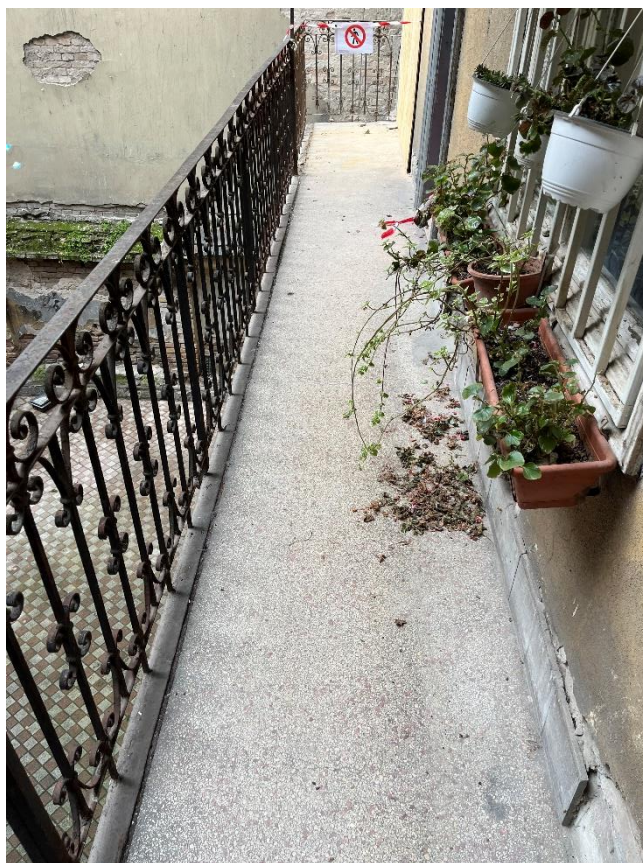
8. számú kép: 1. emeleti függőfolyosó – felülről nézve – 5
