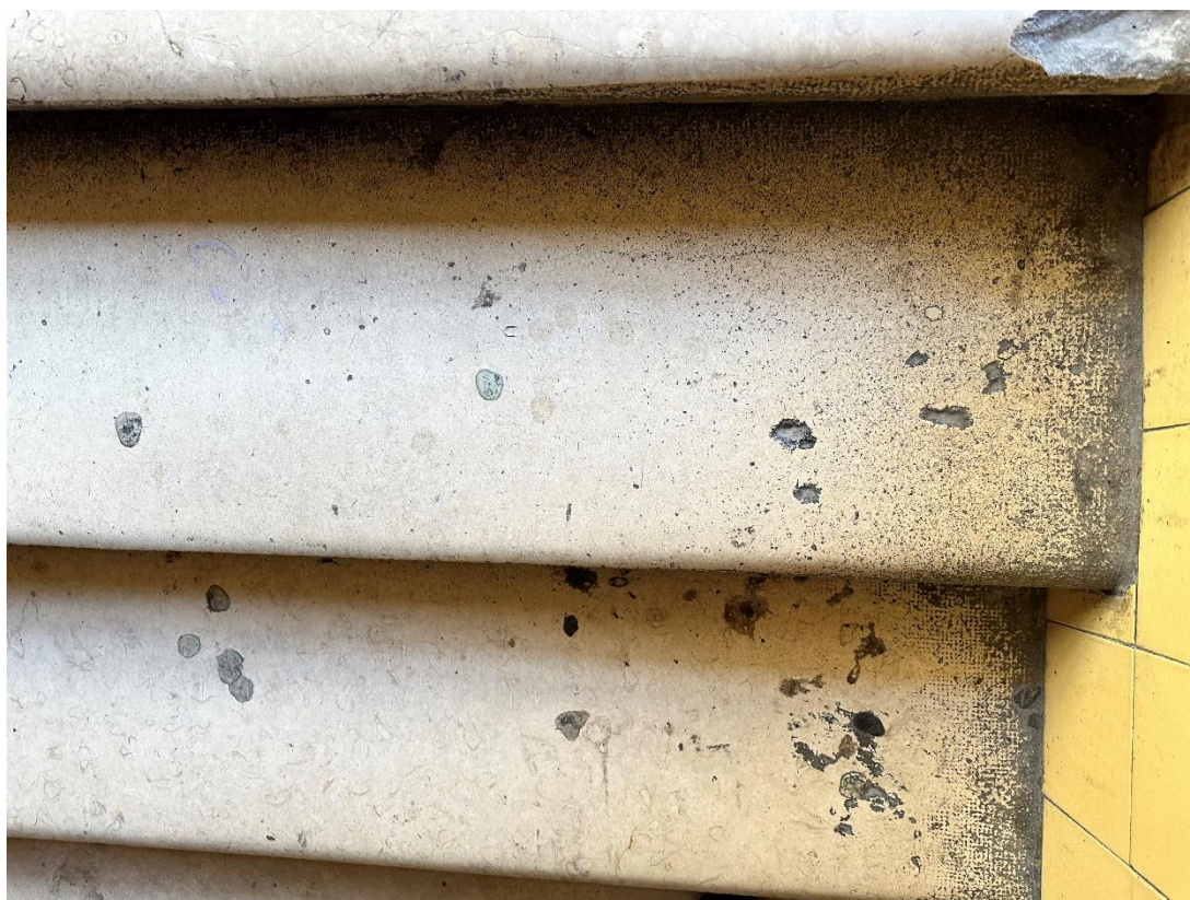
78. számú kép: 3. emeletre vezető lépcsőkar 11. és 12. lépcsőfoka – hossz- és keresztirányú repedések
