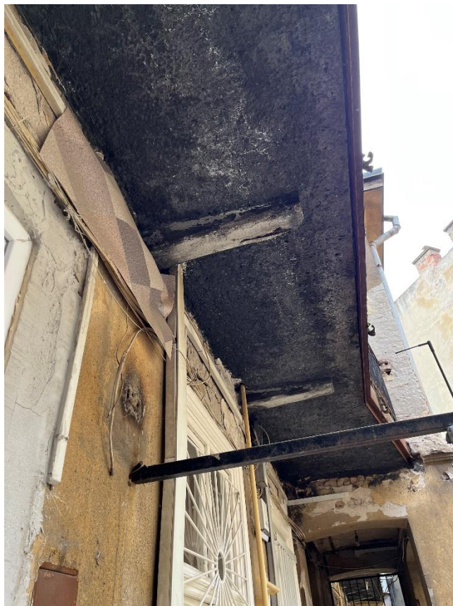
29. számú kép: 3. emeleti függőfolyosó – alulról nézve – 5
