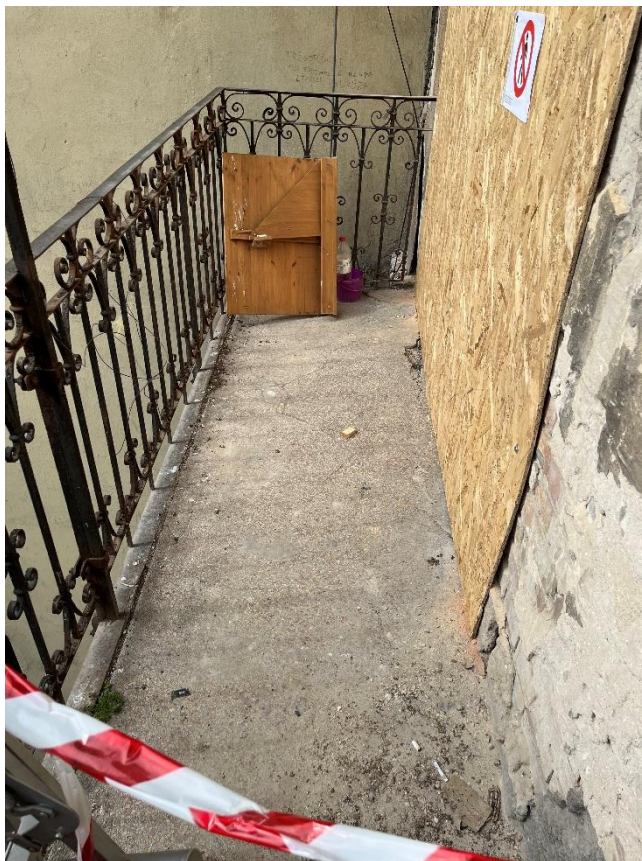
40. számú kép: 3. emeleti függőfolyosó – felülről nézve – 10
