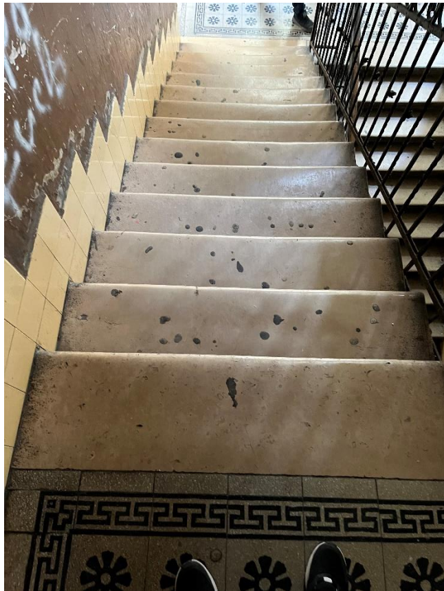
56. számú kép: 2. emelet pihenőszintjére vezető lépcsőkar felülről nézve
