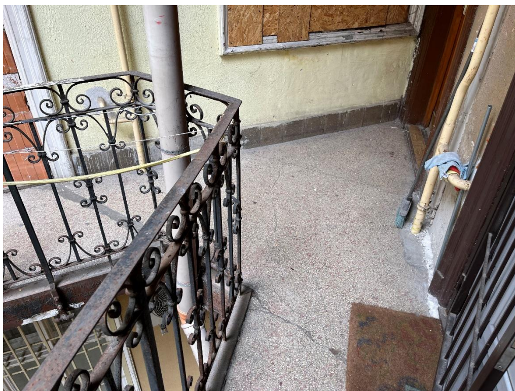
6. számú kép: 1. emeleti függőfolyosó – felülről nézve – 3
