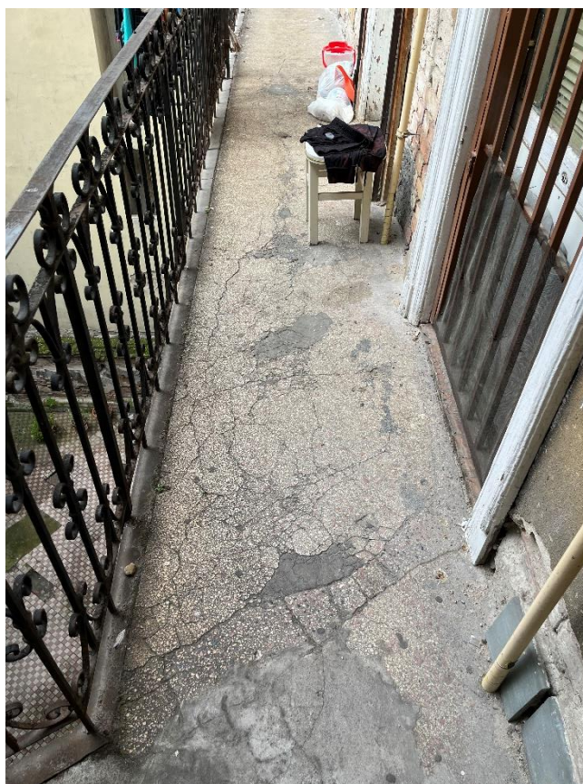
38. számú kép: 3. emeleti függőfolyosó – felülről nézve – 8
