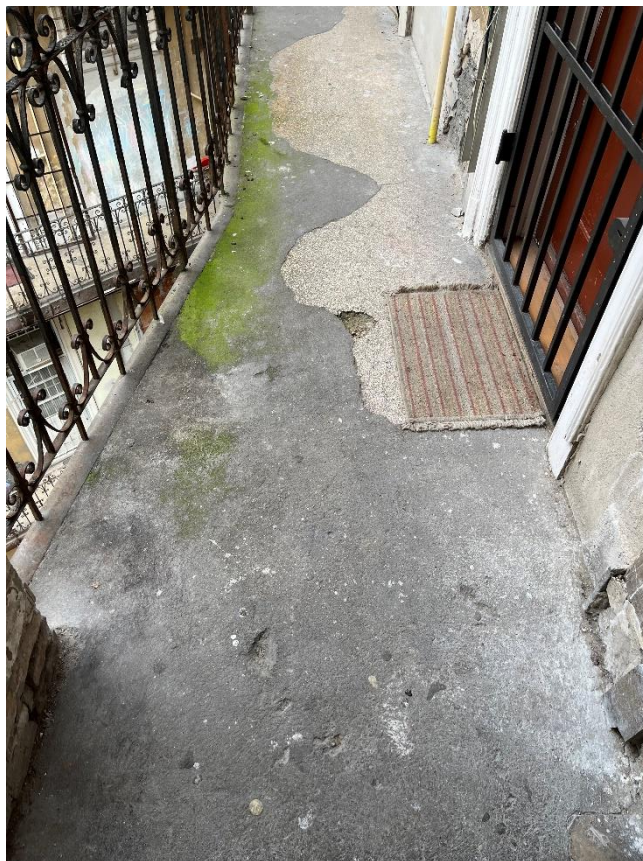
34. számú kép: 3. emeleti függőfolyosó – felülről nézve – 4
