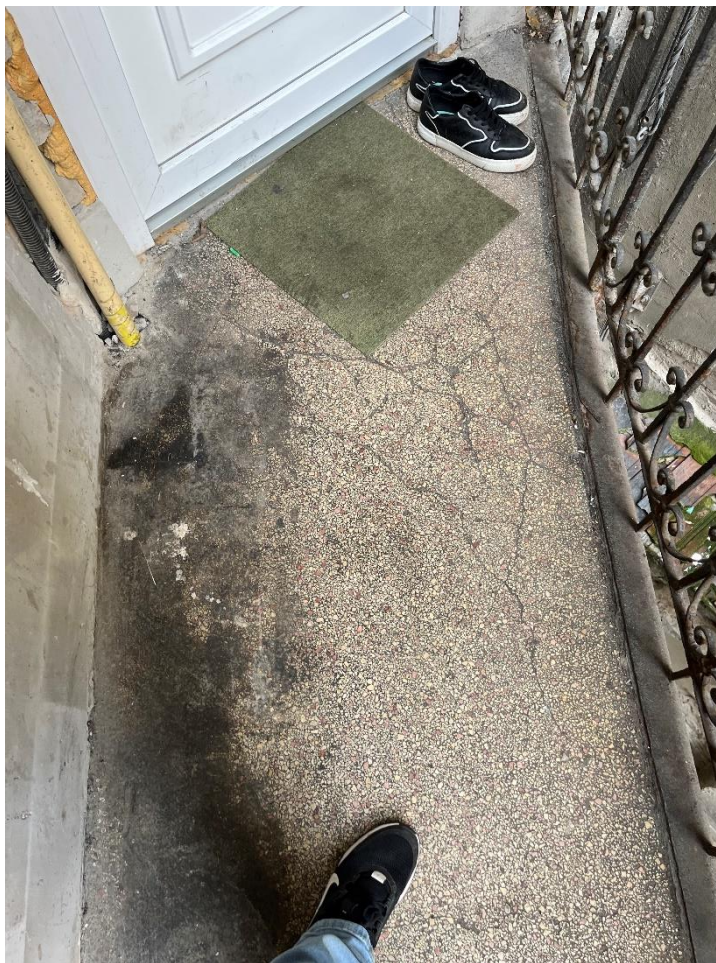
11. számú kép: 1. emeleti függőfolyosó – felülről nézve – 8
