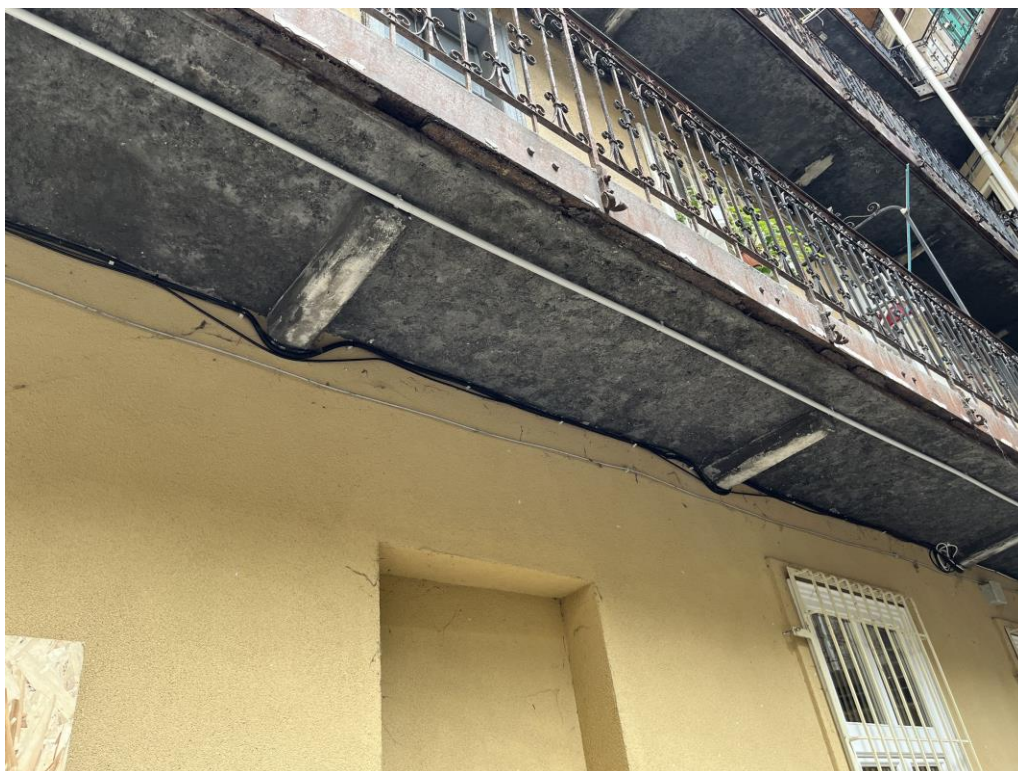
1. számú kép: 1. emeleti függőfolyosó – alulról nézve - 1
