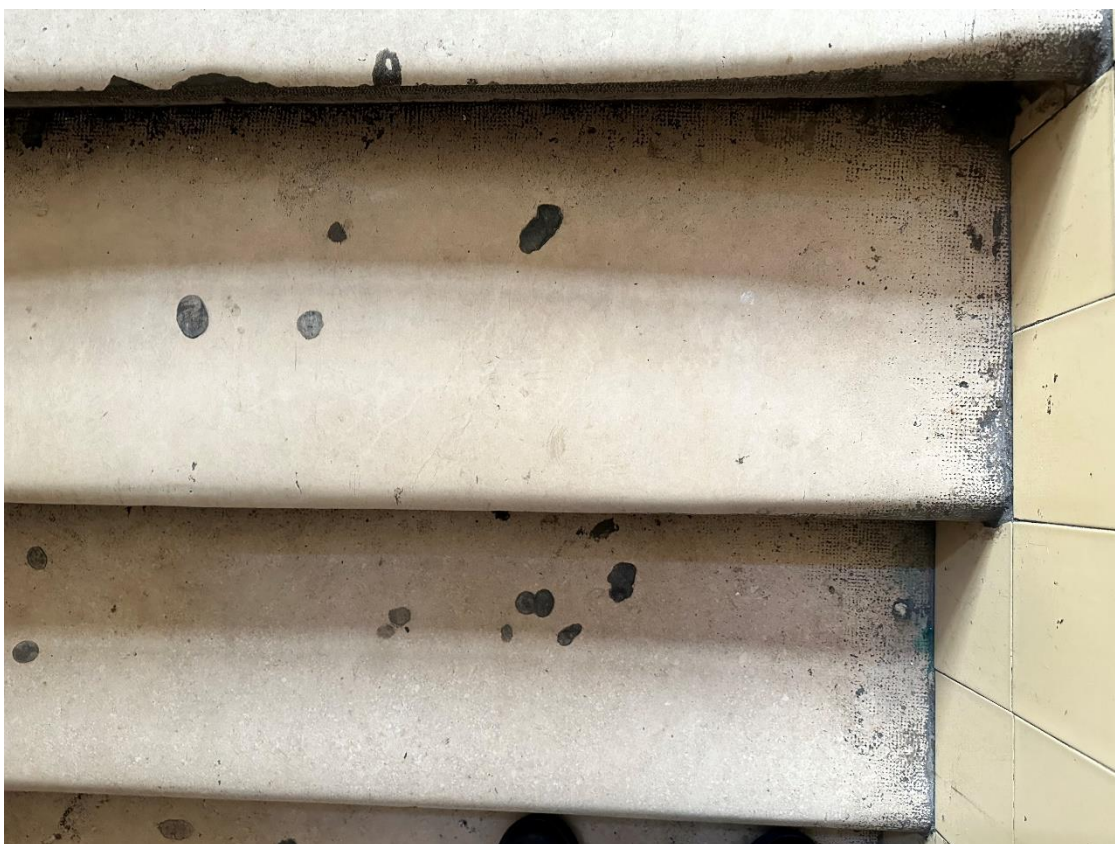
66. számú kép: 2. emeletre vezető lépcsőkar 5. és 6. lépcsőfoka – 6. lépcsőfokon lévő keresztirányú repedés
