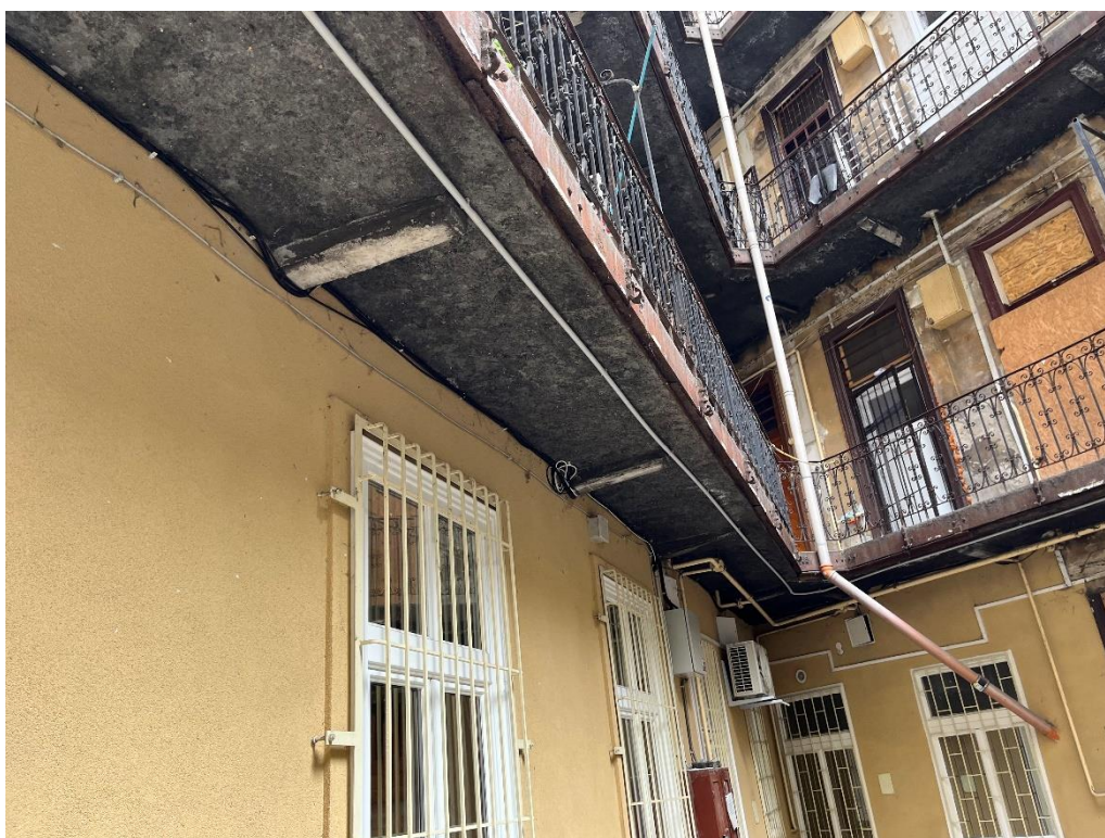
2. számú kép: 1. emeleti függőfolyosó – alulról nézve - 2
