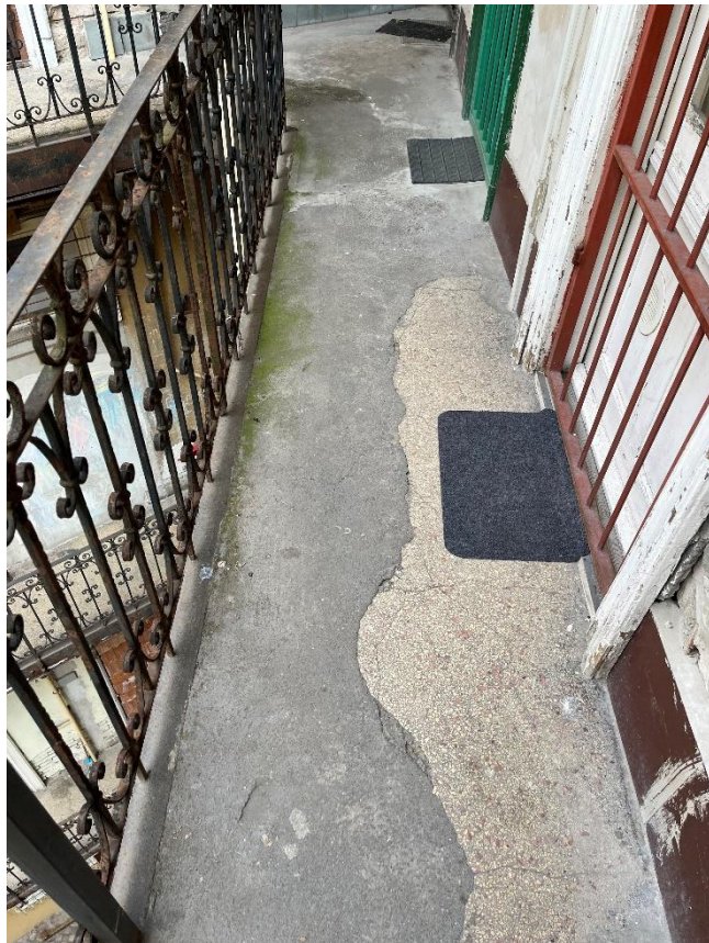
36. számú kép: 3. emeleti függőfolyosó – felülről nézve – 6
