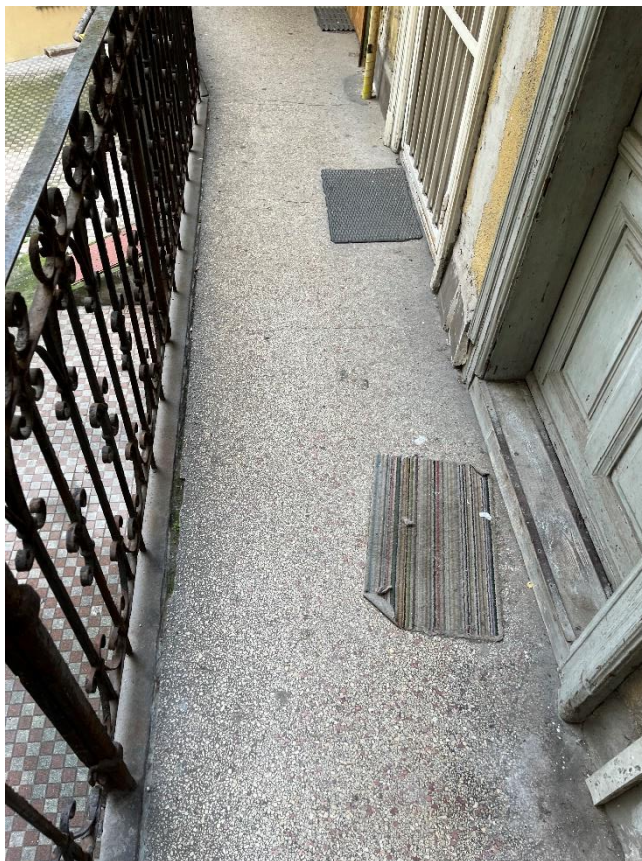
10. számú kép: 1. emeleti függőfolyosó – felülről nézve – 7
