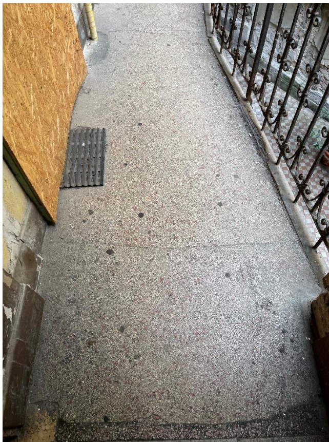
9. számú kép: 1. emeleti függőfolyosó – felülről nézve – 6
