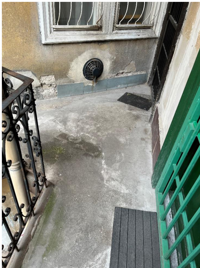
37. számú kép: 3. emeleti függőfolyosó – felülről nézve – 7
