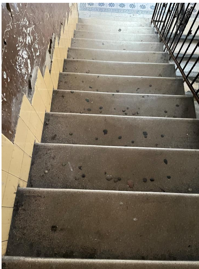
58. számú kép: 1. emelet pihenőszintjére vezető lépcsőkar felülről nézve
