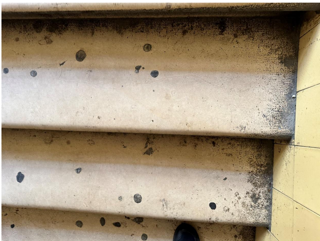
76. számú kép: 3. emeletre vezető lépcsőkar 7. és 8. lépcsőfoka – hosszirányú repedések
