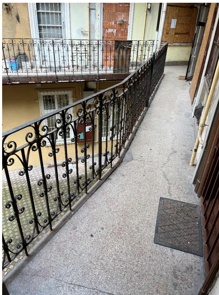
4. számú kép: 1. emeleti függőfolyosó – felülről nézve - 1
