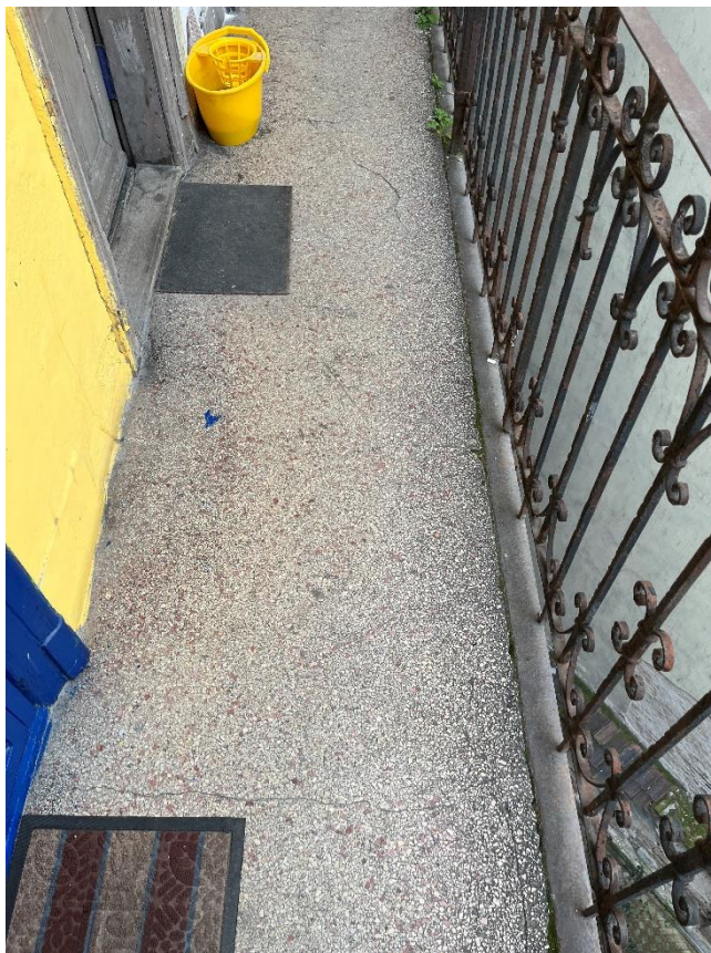
32. számú kép: 3. emeleti függőfolyosó – felülről nézve – 2
