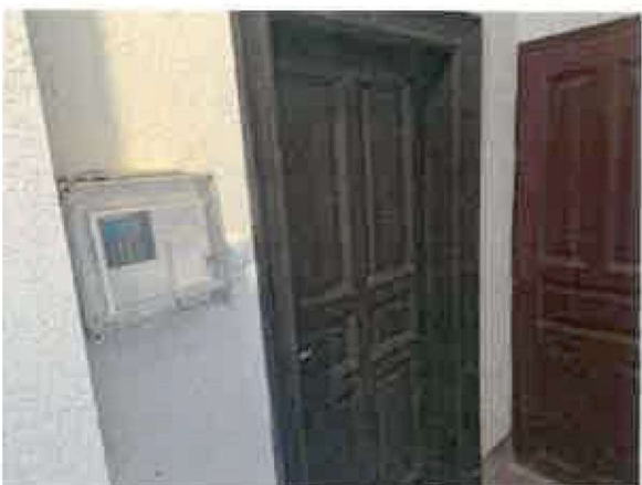
értékelt ingatlan bejárata
