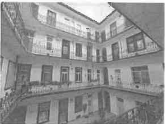
belső homlokzat, közlekedő folyosó
