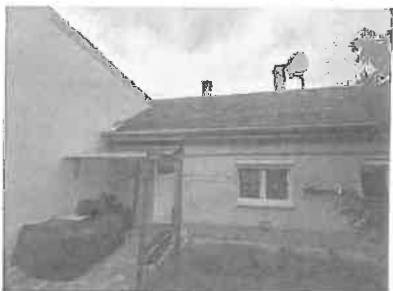
értékelt lakás homlokzata
