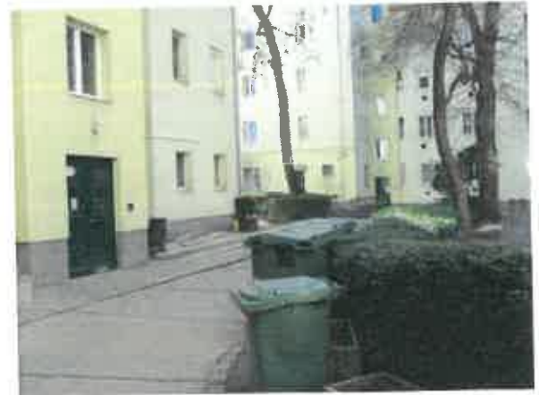
társasházi tömb belső udvari homlokzata
