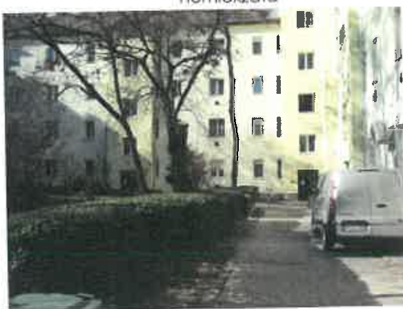
társasházi tömb belső udvari homlokzata
