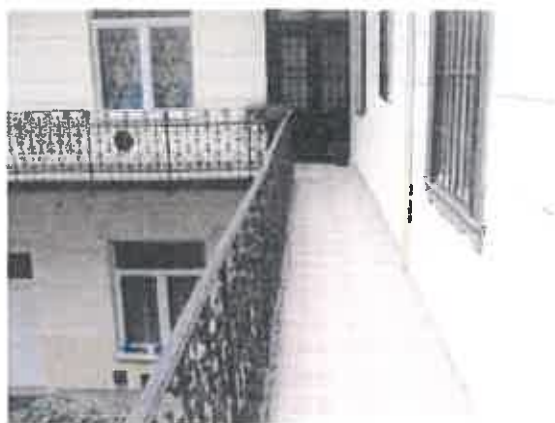
belső homlokzat, közlekedő folyosó
