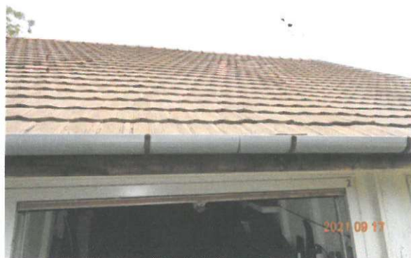
Tetőszerkezet, ereszcatorna
