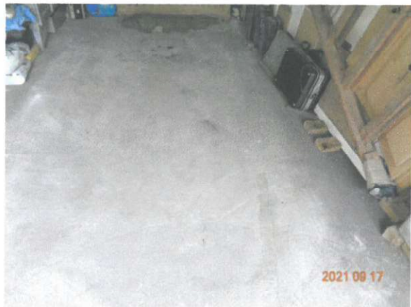
Simított beton padozat
