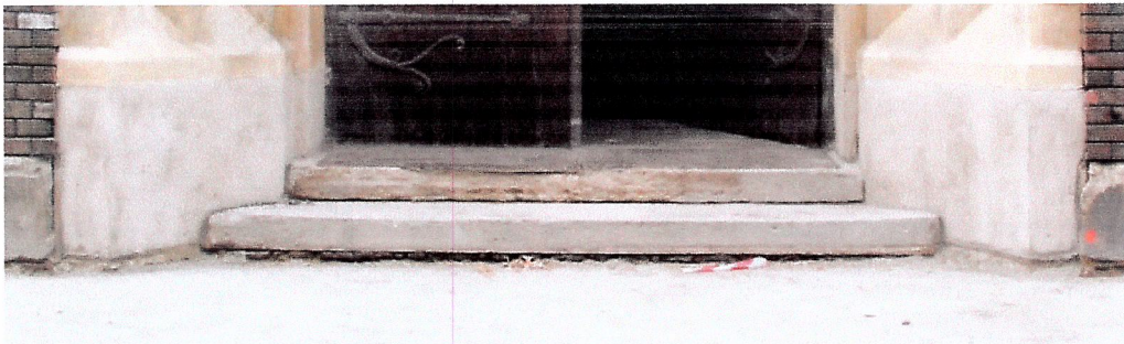
A lépcsők állapota a közút felújításakor.
