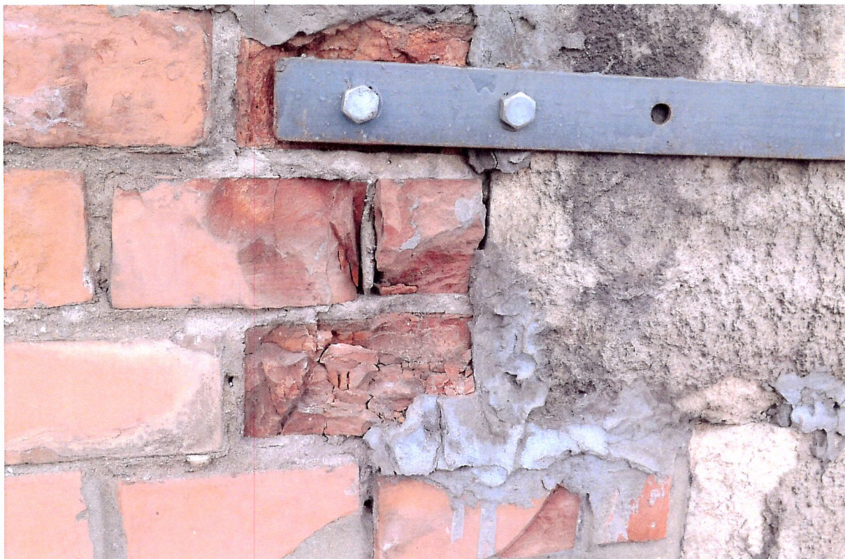
A tornyon acélpántokkal biztosított kövek állapotát rendszeresen ellenőriztetjük.
