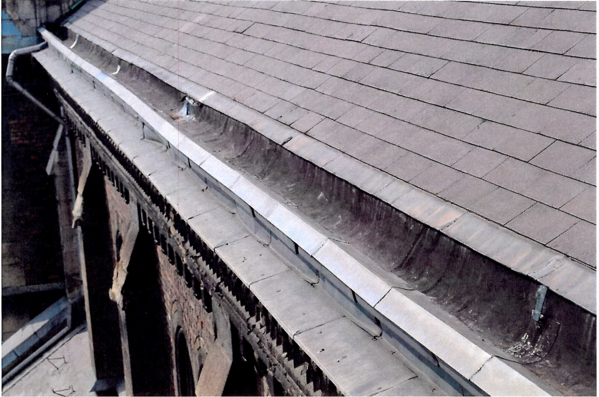
A főhajó déli oldalán futó kívülről álcalemezzel fedett, béleléssel javított ereszcsonna.
