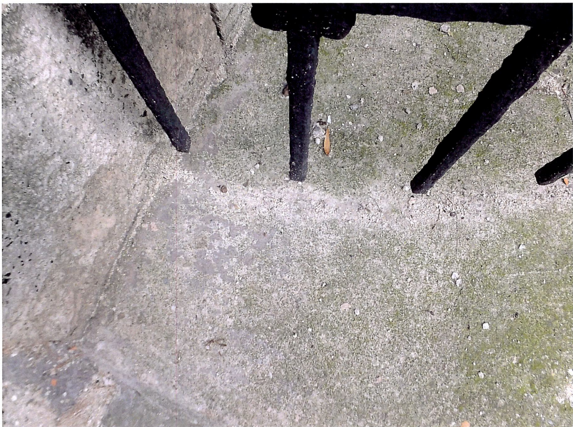
A fenti homlokzatról folyamatosan pergő apró kő-morzsalék az alatta lévő járdán.
