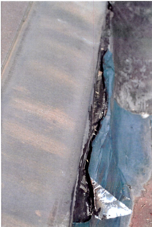
A főhajó déli oldalán futó kívülről álcalemezzel fedett, béleléssel javított ereszcsonna.
