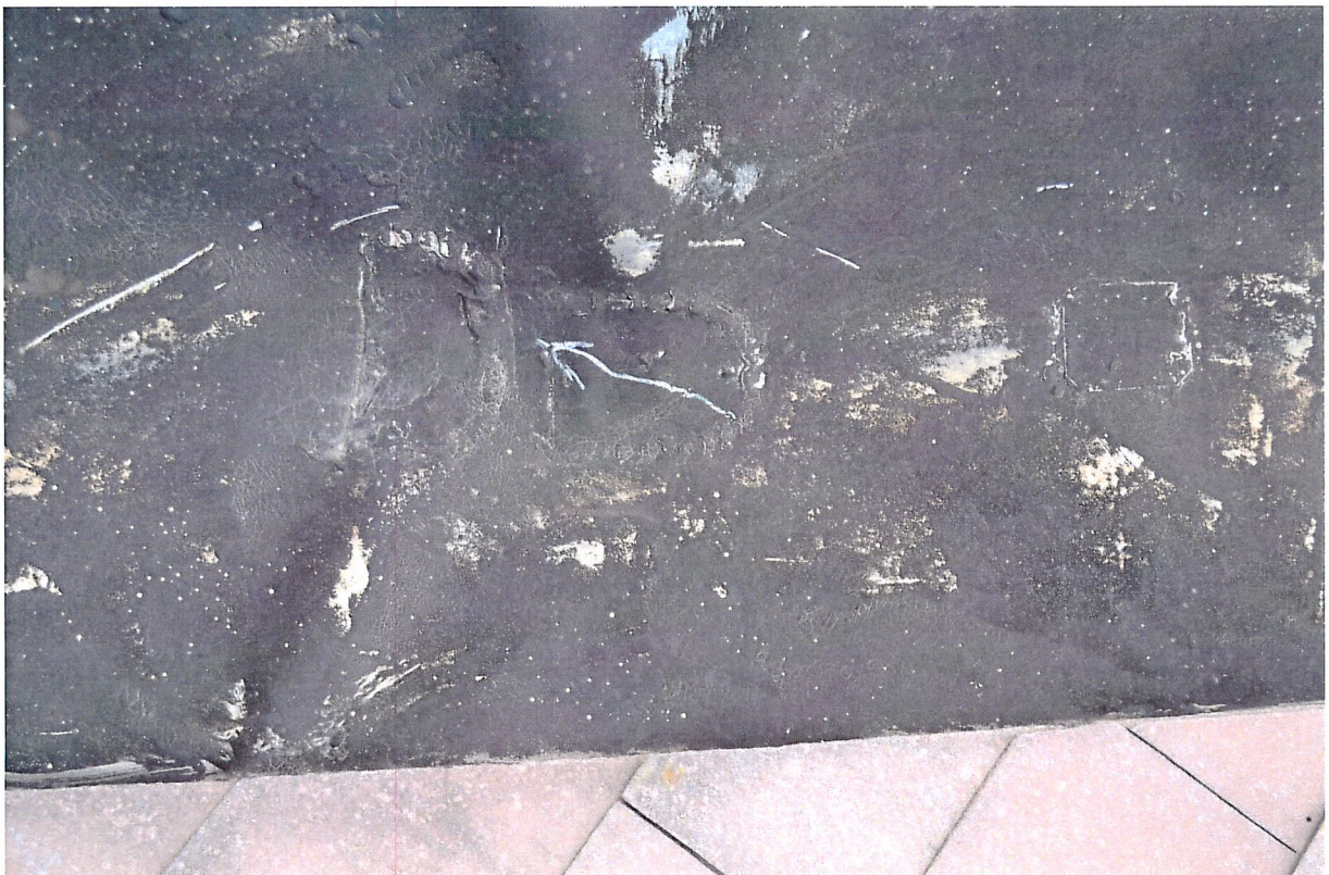
A cserélendő hajlatbádogon levő repedések
