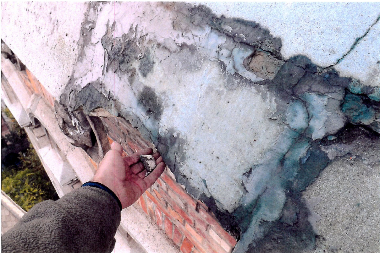
A torony egyre „fogyó” kőburkolata a harangkamra feletti párkánynál.
