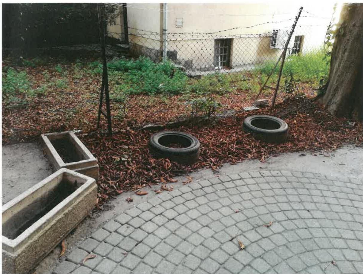
1. ábra meglévő beton kerti ládák
