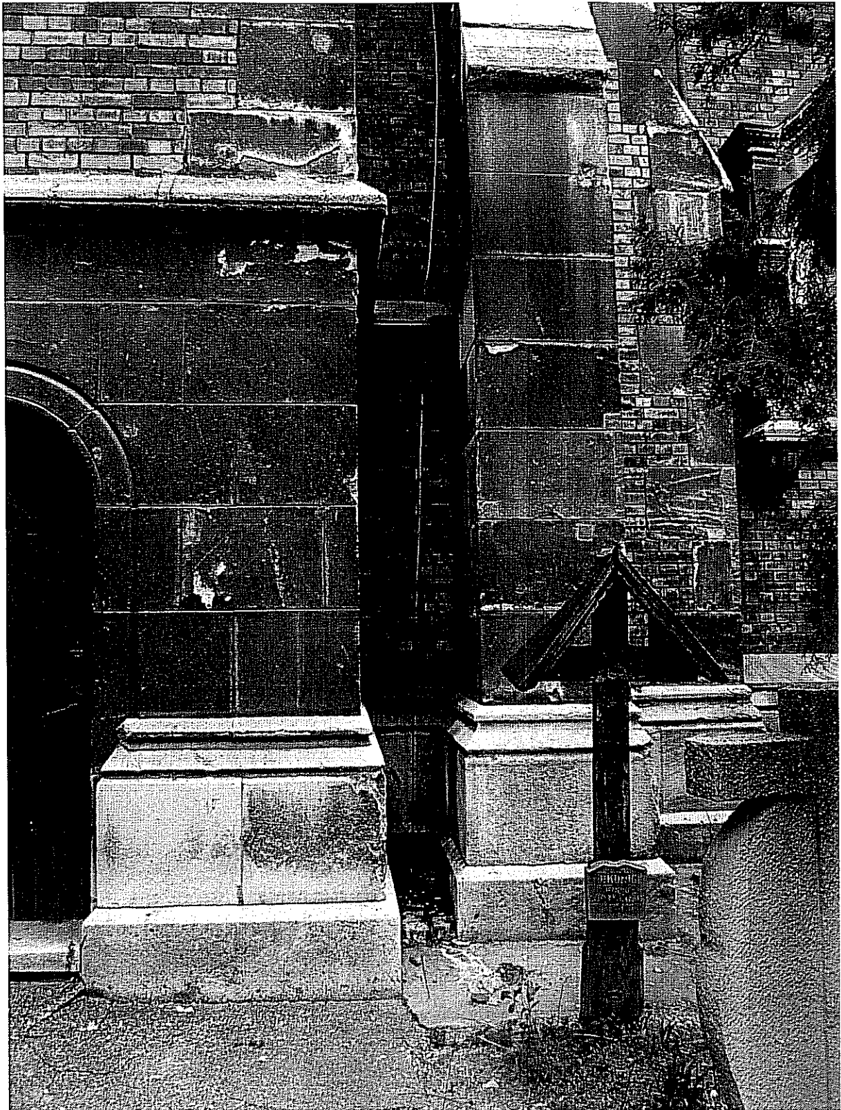
Villámhárító levezetés és földelés a torony északi oldalán kis keresztmetszetű rézsodronnyal, amit nagyobb keresztmetszetű alumíniumsodronyra kell cserélni.
