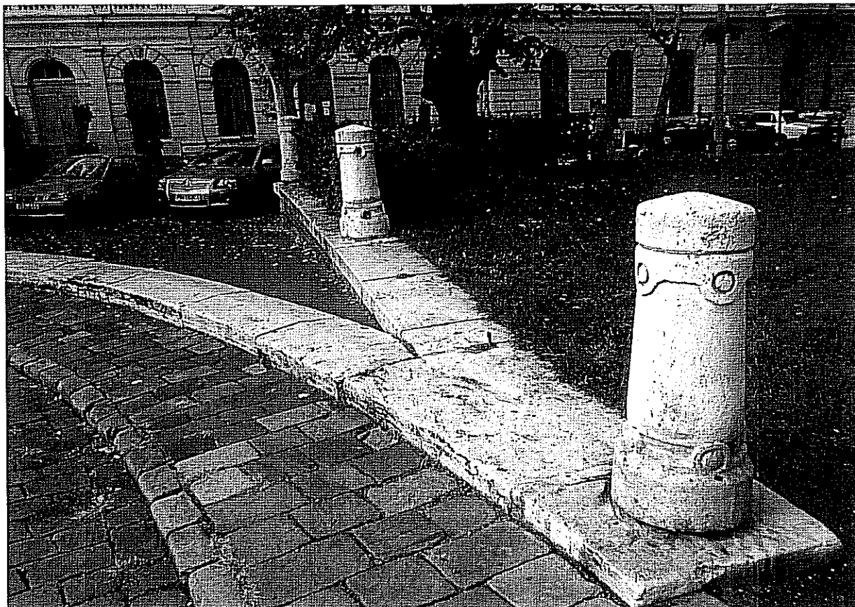
A terasz-korlát kitört szakasza
