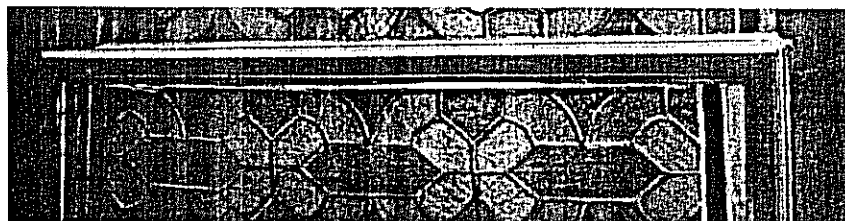
A meggyott, tartását vesztt üveg keretből való kicsúzásának példája
