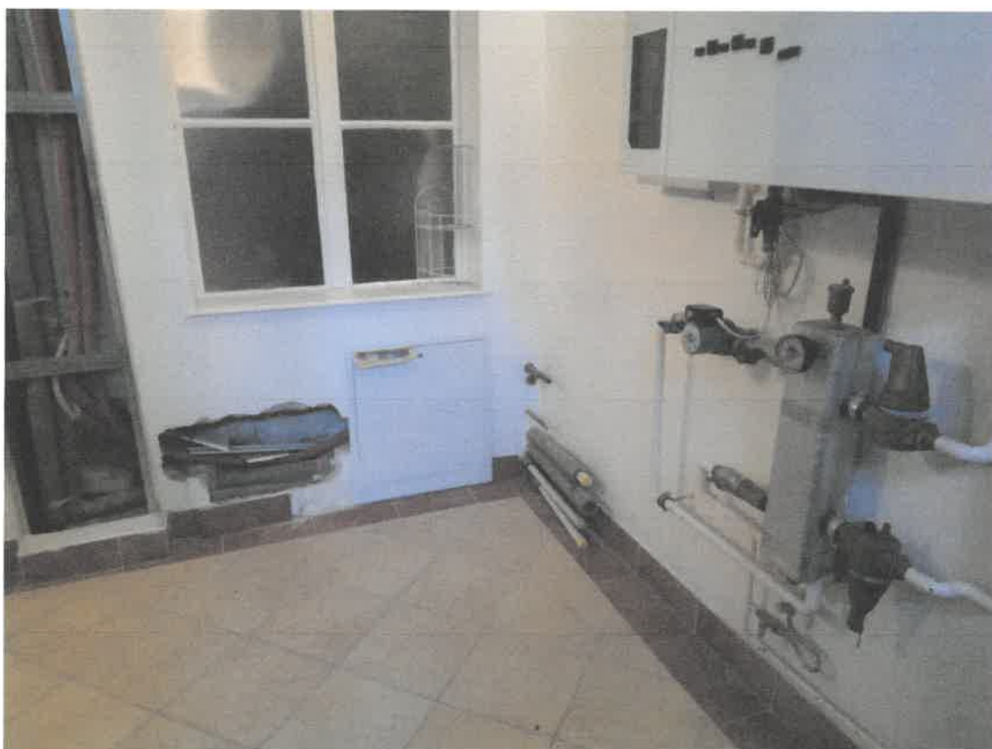
A földszinti és az emeleti fűtési rendszerek összekapcsolása
