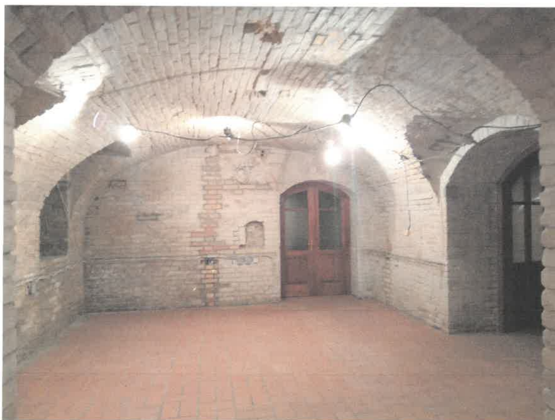
Ideiglenes kábelek, megépült új alapvezeték hálózat
