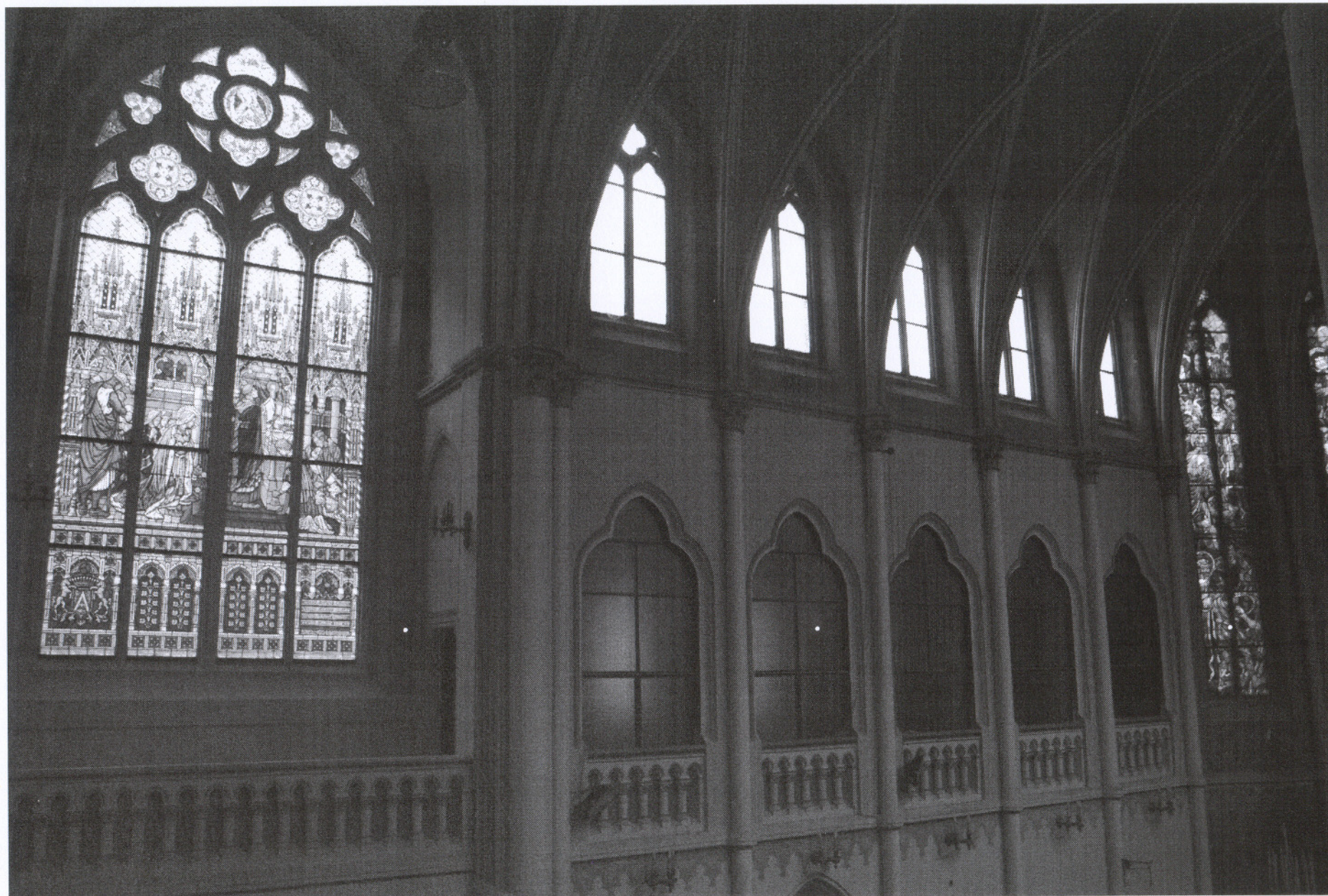
12. A már elkészült és a rekonstruálni tervezett ablakok
