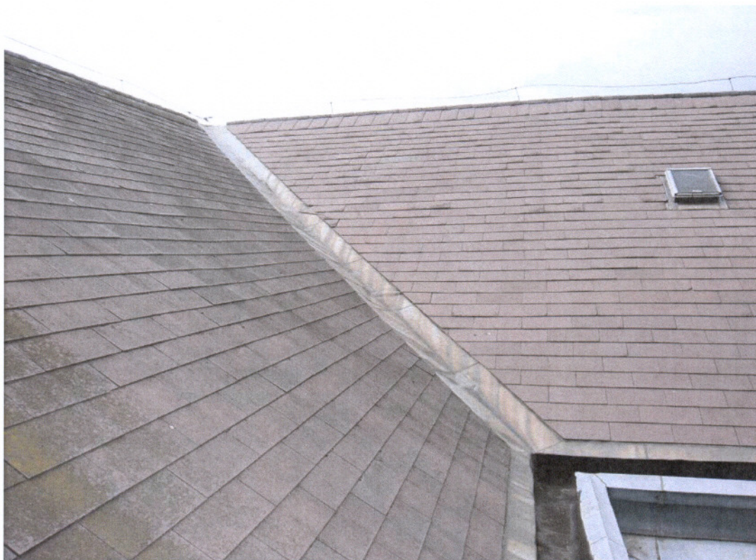
Vápa a főhajó és kereszthajó csatlakozásánál a 2010.-ben bélelt csatornával.
