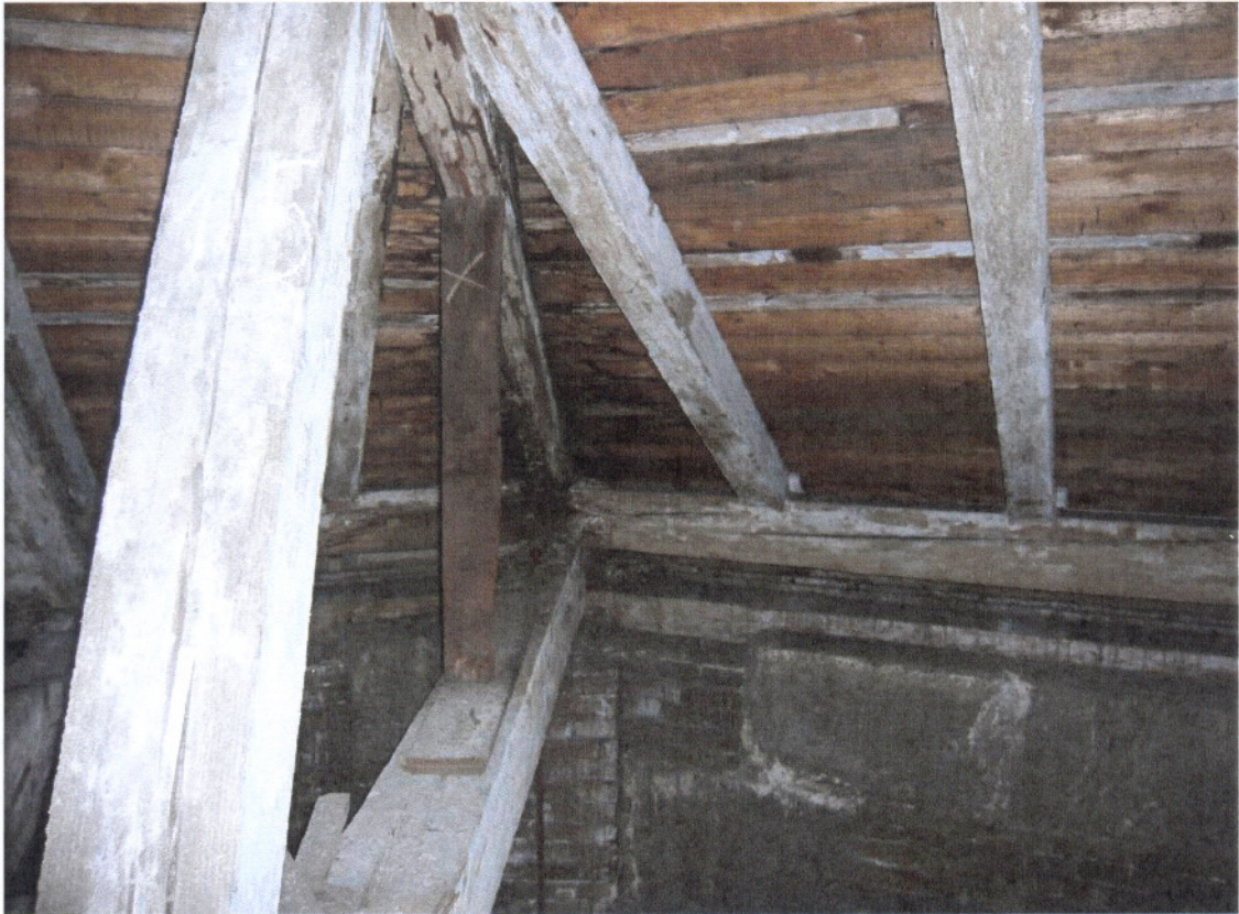
A szentély a feletti tető részlete, ahol a deszkázatot védőkezeléssel kell ellátni.
