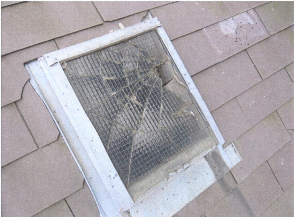
A torony mögötti világítóablak drótüvegét egy leeső kődarab átütötte
