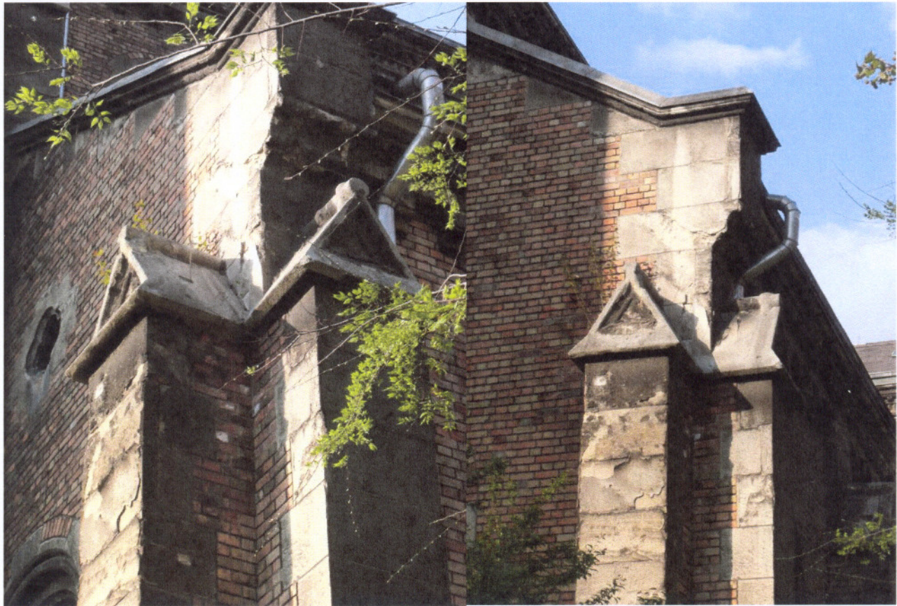
A déli oldalhajó DNY.-i támpillére fedkövének üregeiben megülő növények, amelyek a belső térben is nedvesedést, foltosodást okoznak.
