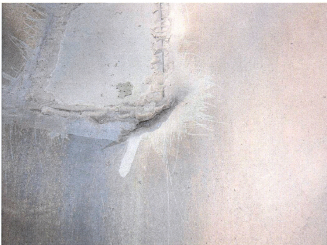
A fenti vápa horganylemezőnek egyik repedése.
