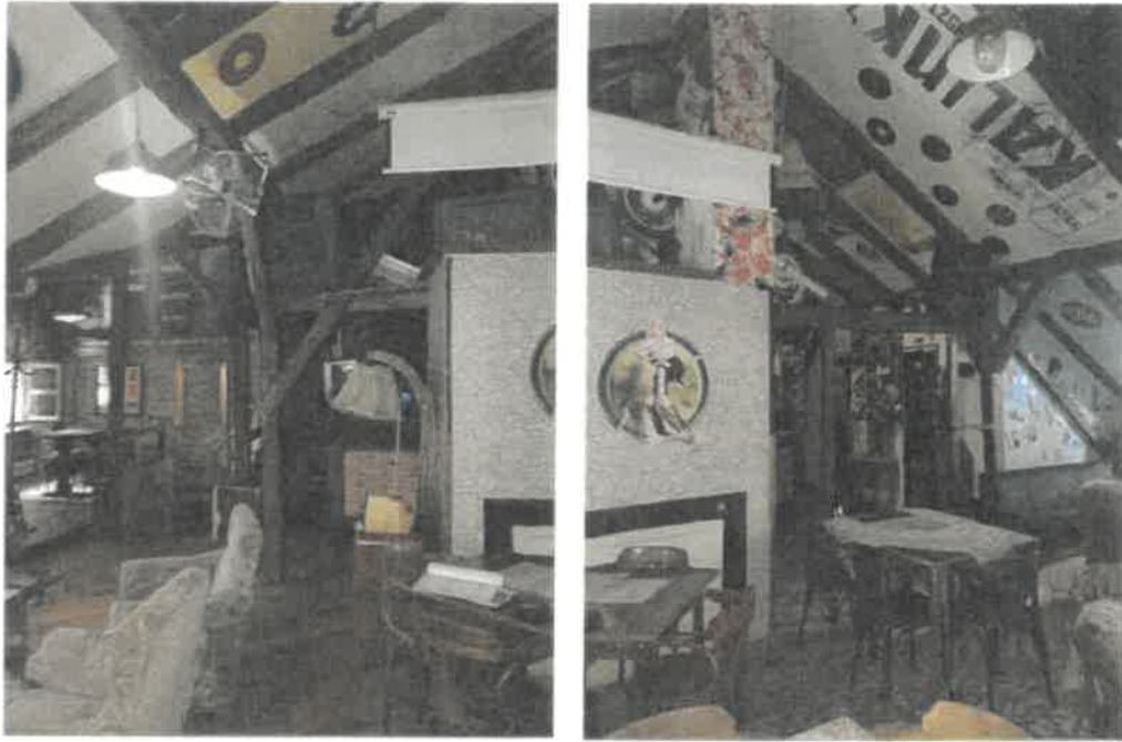
Az étterem beépített tetőtere
