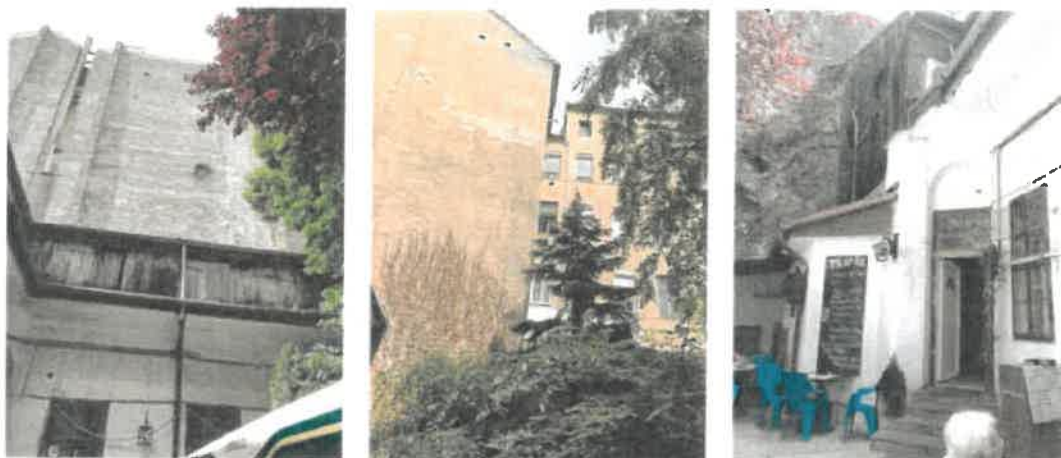
Belső udvar, szomszédos épületek tűzfalai
